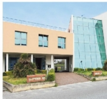
L'ingresso della sede operativa del Consorzio
