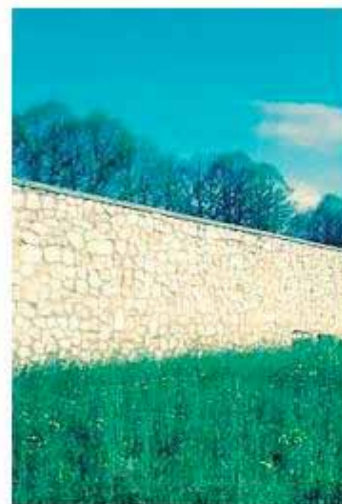
Il muro di contenimento
